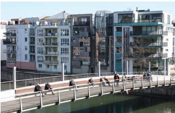
Leben am Fluss: Direkt an der Fulda entstand in den vergangenen Jahren ein neues, zentrumsnahe Wohnquartier in der wiederaufgebauten Unterneustadt.
