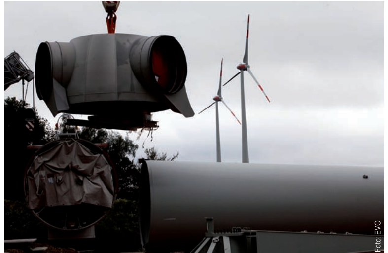
Die Montage der Windenergieanlagen in Kirchberg
